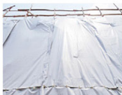
Construction site 工地
