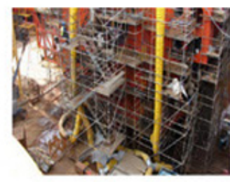
Construction Site 建筑工地
